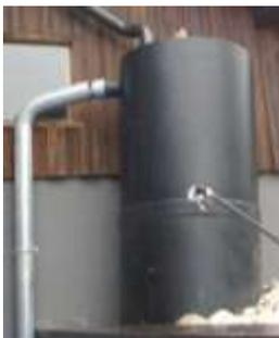
Ein sehr effizientes System ist die Einleitung des Dachrinnenwassers in eine **große Vorratsstonne mit Überlauf**. Die Ableitung führt zu einer zweifachen Wasser-Entnahme-Stelle im Garten. Bei einem Höhenunterschied von 5 Metern sind 0,5 bar und bei 10 Metern 1 bar Druck in der Leitung. Das System funktioniert ohne Strom.
