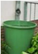
Ein sehr einfaches System ist das **Ableiten von Wasser aus der Dachrinne** mit einem in die Dachrinne integrierten Schnabel. Nachteil: Bei Gewitterregen und geöffneter Klappe kommt es schnell zu Überschwemmungen.
