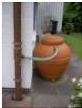
Ein neueres System ist ein in die Dachrinne integrierter „**Wasserdieb**“, der für ca. € 40 angeboten wird. Bei diesem System gibt es kein Überfüllen mehr. Ein geschlossener Auffangbehälter ist aus Sicherheitsgründen zu bevorzugen.
