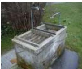
Falls kein Regenwasser zur Verfügung steht, entnimmt man r beim zweiten Wasserhahn Wasser aus der Wasserleitung. Um eine Verwechslung zu vermeiden ist das Trinkwasser und Nichttrinkwasser zu kennzeichnen. Dieses System kann auch auf einem Balkon untergebracht werden.
